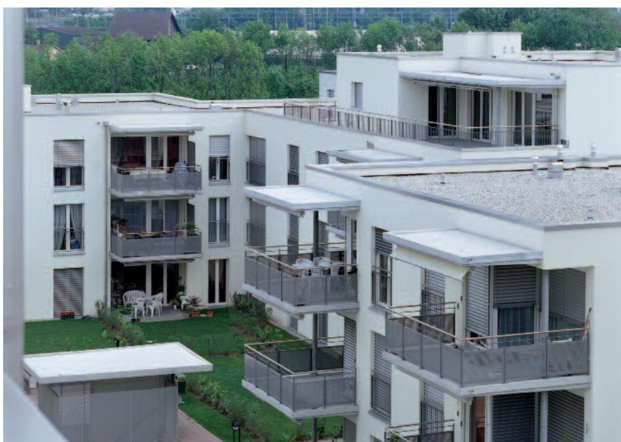
L'utilisation de méthodes constructives rationnelles, telle que la préfabrication des escaliers et balcons, d'éléments porteurs et de modules de serrurerie répétitifs ont permis de réaliser l'ensemble de plus de 33'000 m<sup>3</sup> SIA en moins de 16 mois, pour un coût de construction contenu.
